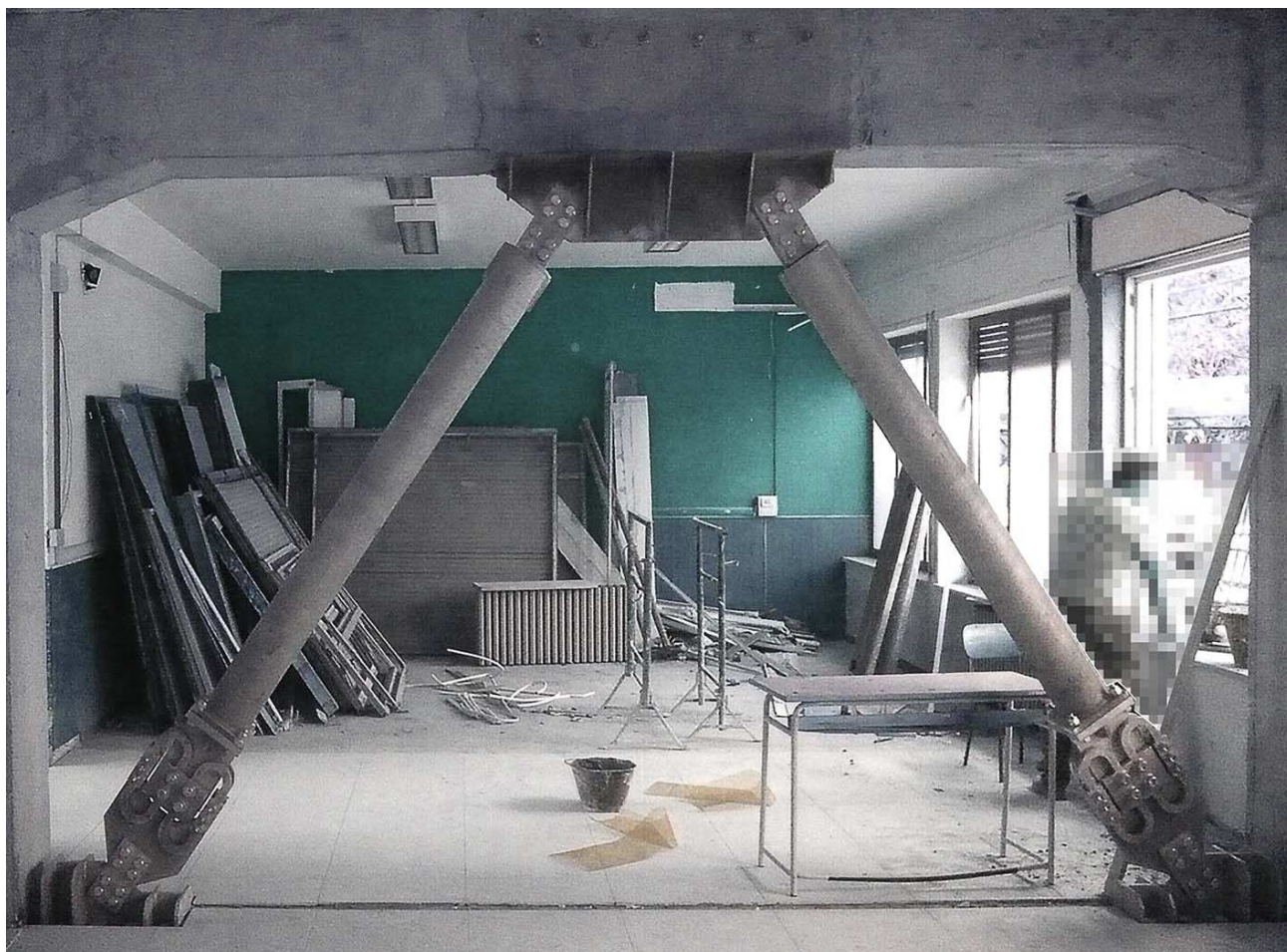
Installazione di controventi dissipativi
